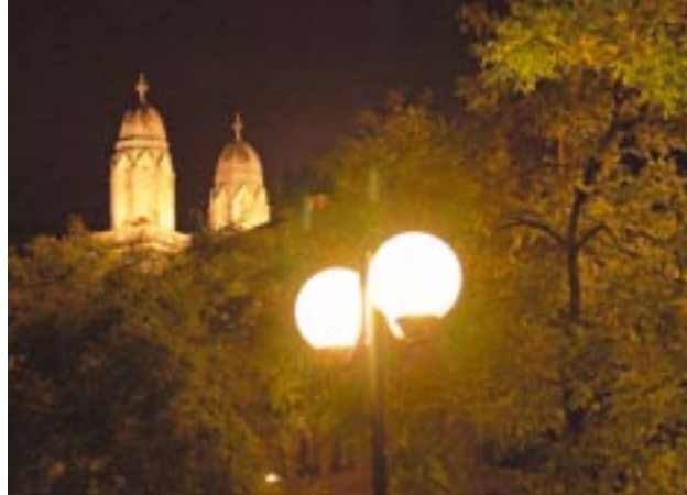
Kugelleuchten, seit den 1970er Jahren oft verwendet, strahlen ihr Licht nach allen Seiten in den Nachthimmel. Sie sollen nach Möglichkeit ersetzt werden.
